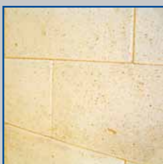
Spáry bez tmelu chrání cihly před praskáním. Špáry bez tmelu chránia tehly pred praskaním.
